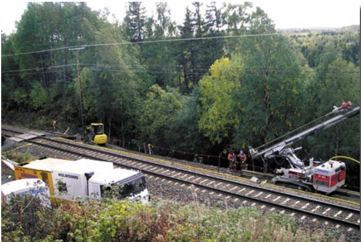
Det är trångt mellan spåret och branten. Arbetet kräver skärpt uppmärksamhet.
