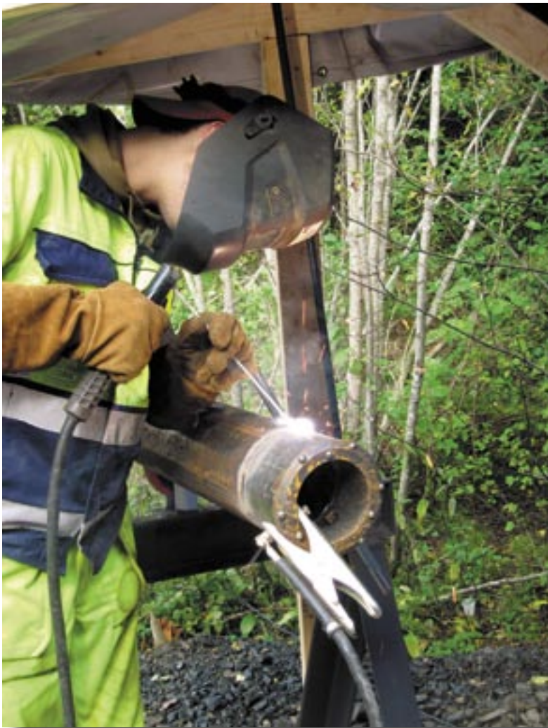
En ekonomikrona specialdesignad av Lifa AB svetsas fast på ett av foderrören av Dennis Eriksson på Brunnsborrharna Rehn & Sjöberg AB. Foto: Erica Lång
