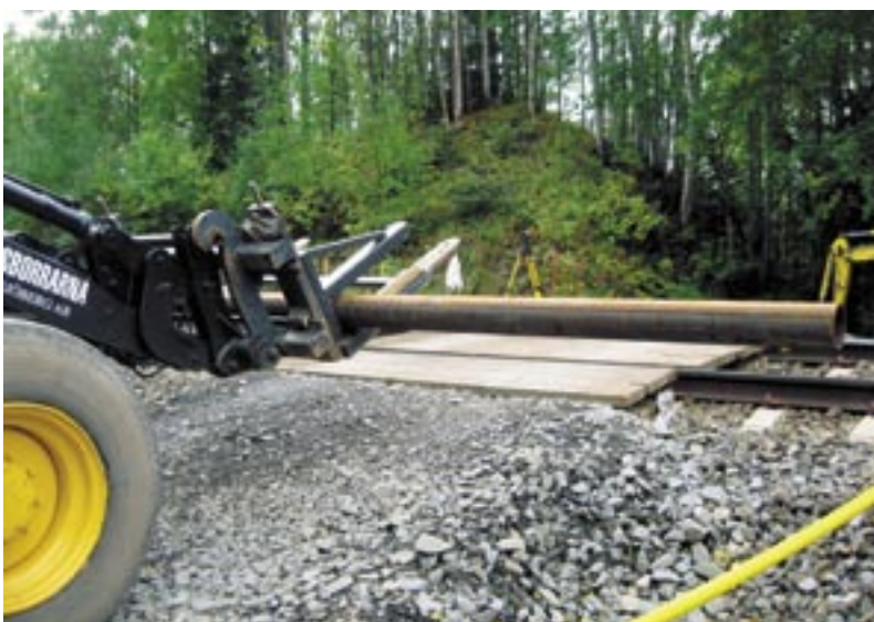
En rörhanterare har konstruerats av Brunnsborrharna Rehn och Sjöberg. Den håller de sex meter långa järnrören på plats när traktorn kör över järnvägsspåret. Foto: Erica Lång
