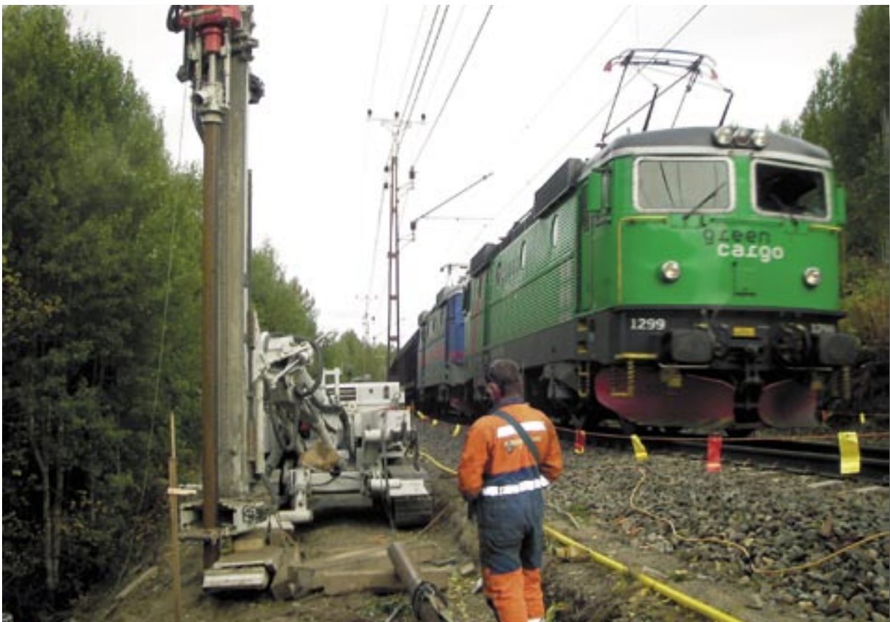
Mellan järnvägen och branten på 30 meter säkras vällen snett utanför riggen.
